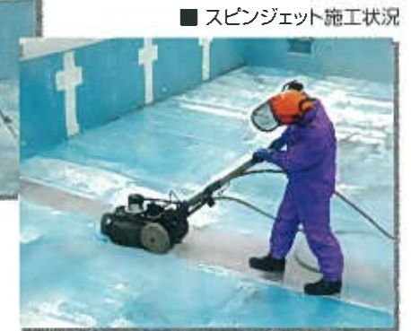
■ スピンジェット施工状況
