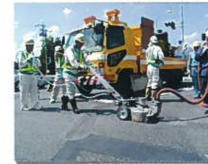
■ 国道135号 長野県飯田市
