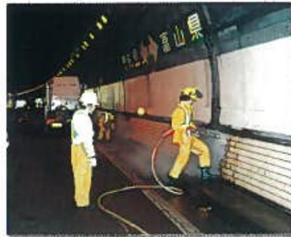
■ 北陸自動車道 富山・石川県境トンネル
