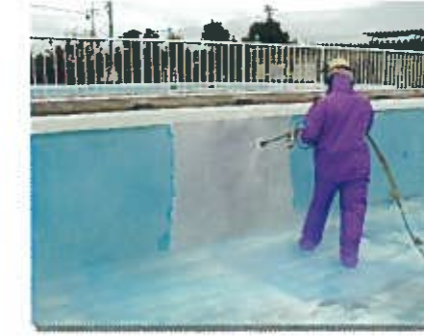
■ ハンドガン施工状況
